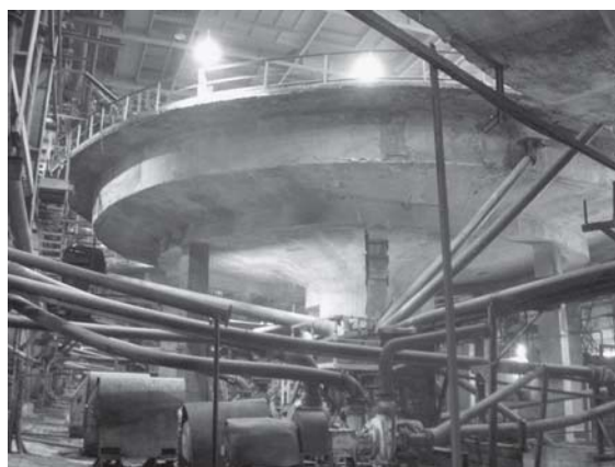
Рис. 2. Обогащительная фабрика: конструкция повышенной ответственности — чаша сгустителей
