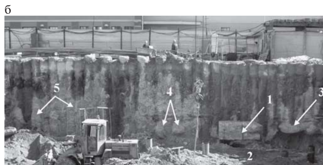
Рис. 5. Результаты зондирования после проведения фокусировки (а) и стена котлована, выкопанного на месте зондирования (б)
