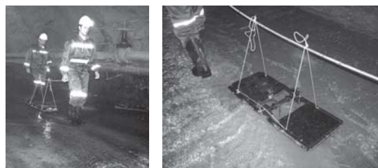
Рис. 3. Зондирование георадаром «ТР-ГЕО-02» в технологической штольне транспортного тоннеля
